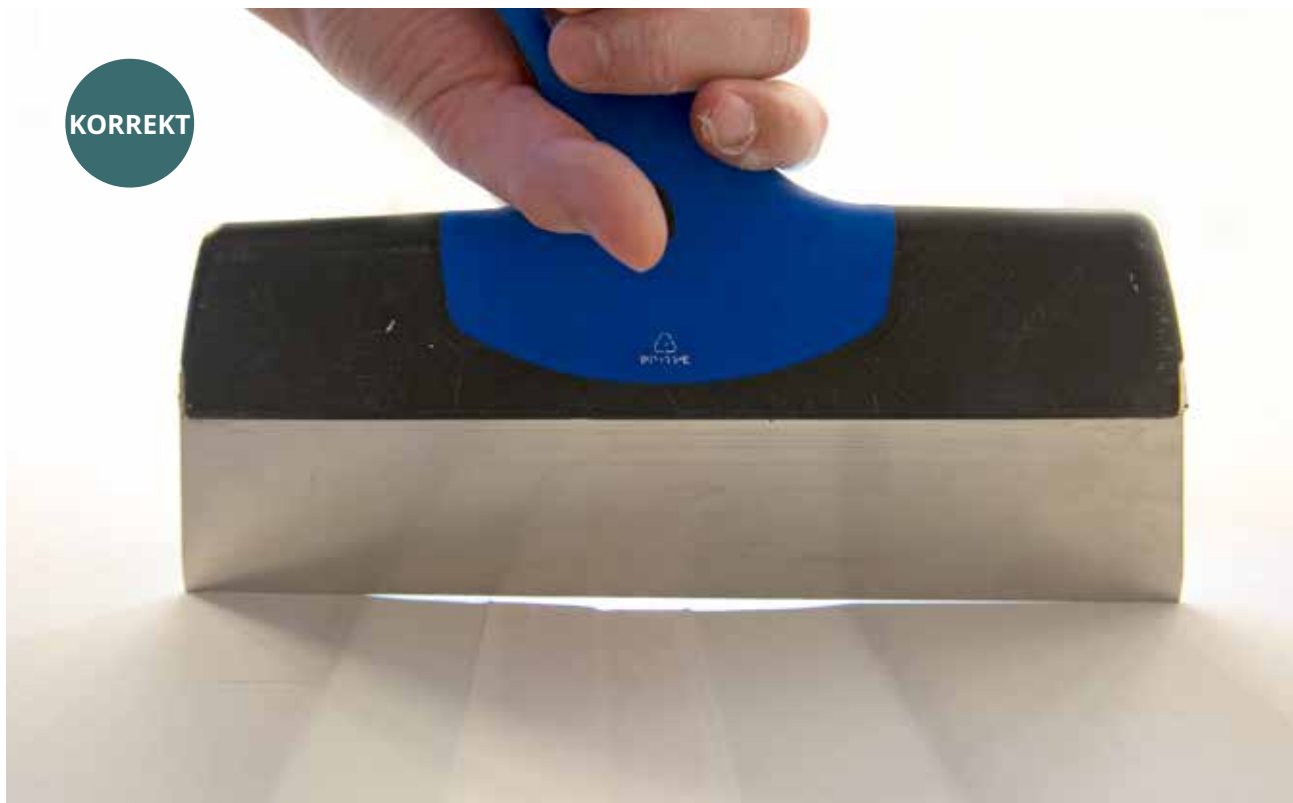
Korrekt spackellager under spackelremsan efter spackling.
